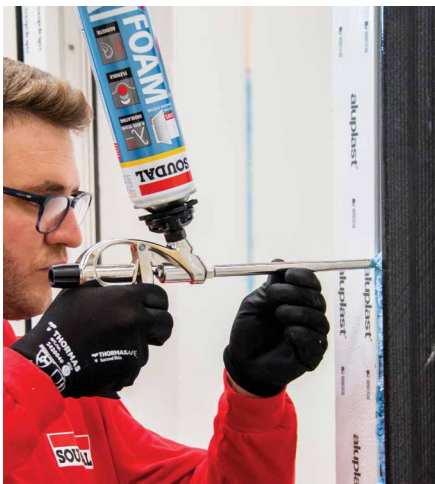
15 Eemaldage vedrulõksud ja täitke kinnitusrämi ja aknaraami vaheline vuuk
