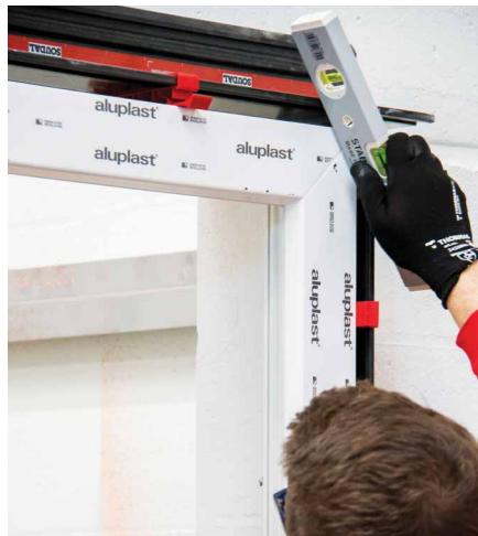
13 Puurige aknaraami sisse kinnitusavad, pange raam oma kohale ja joondage
