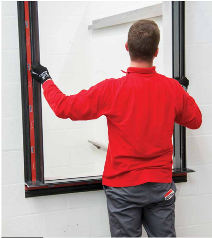
09 Tõstke raam üles ja suruge see vastu seinä, liigutades üles-allä ja vasakule-paremale
